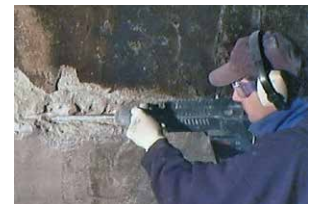
Rehabilitación Patch'n Plug & Megamix
