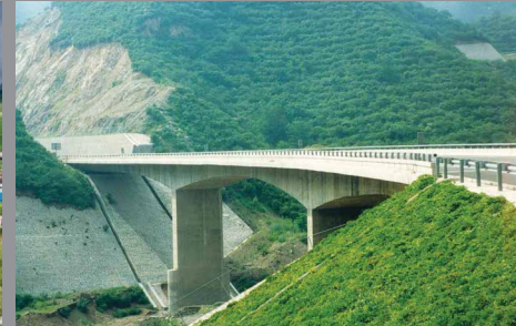
Puente Vial Badaling, China
