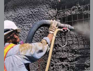
Concreto lanzado
