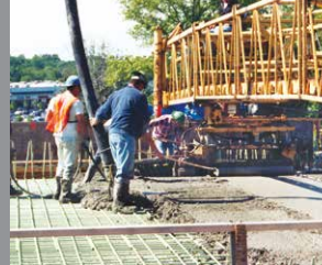
Concreto vertido en sitio
