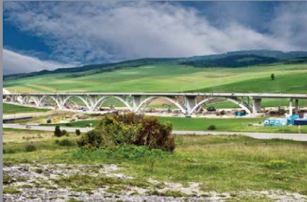
Puente de Autopista D1, Eslovaquia
